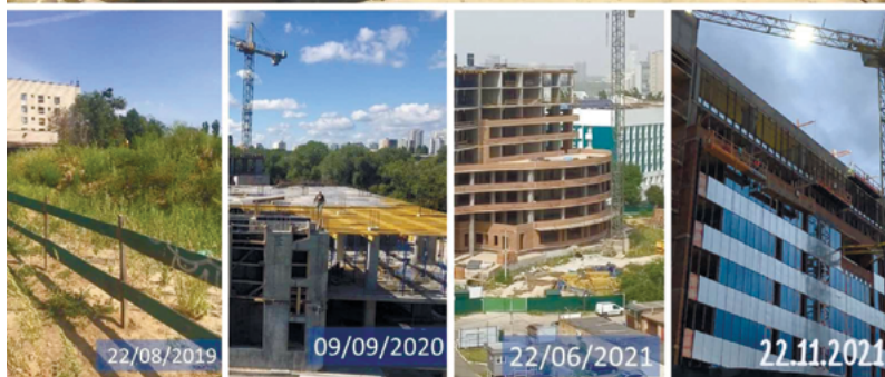
Команда однодумців на чолі з академіком В. В. Лазоришинцем крок за кроком йде до розбудови сучасної лікарні мрії. Динаміка будівництва нового корпусу з 2019 по 2021 рік
